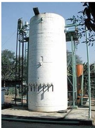
Figura 14 - Biodigestor no CTH
