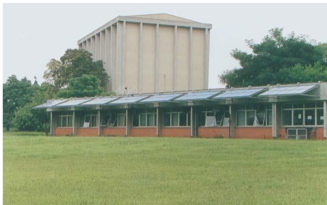
Figura 12 - Painéis fotovoltaicos instalados no IEE
